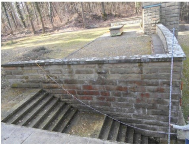
Abb. 14 Ansicht Stützmauer Treppe Ost, Westseite
