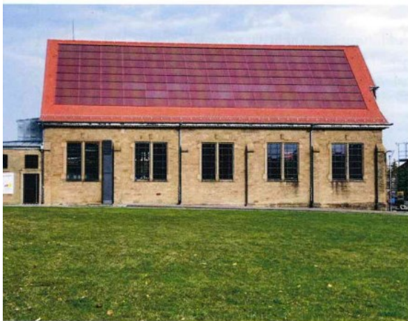
Die sanierte Turnhalle mit ihren bauintegrierten, roten PV-Modulen.
